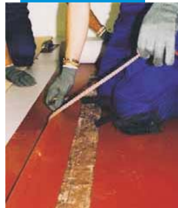
Odstranění části nařezané podložky Mapelay
