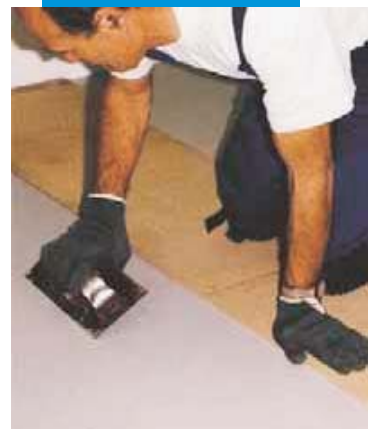
Vyhlazení podlahy v kleče na tuhé desce, aby se zabránilo otisku kolen do podlahy
