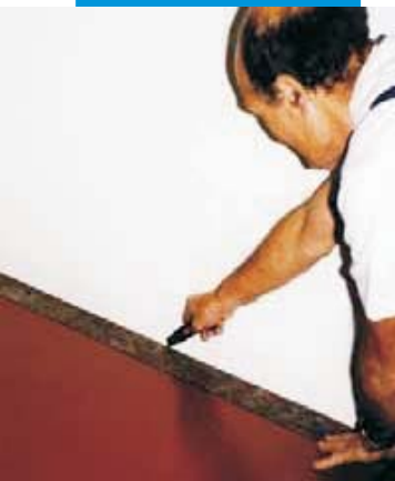
Pokládka Mapelay a provádění 5-10 mm distanční mezery ve styku podlahy se stěnou
