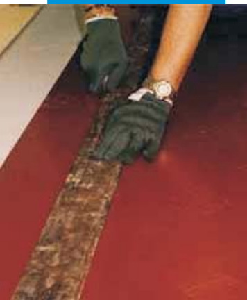
Řezání spoje mezi pásy Mapelay
