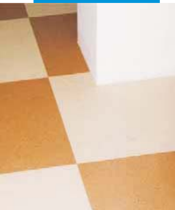
Podlaha z gumových šablon položených na Mapelay
