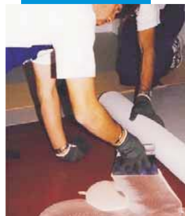
Pokládka gumové podlahové krytiny na podložku Mapelay pomocí Adesilex G19. Poznámka: styky spojů mezi gumovou krytinou a podložkou Mapelay jsou posunuté.
